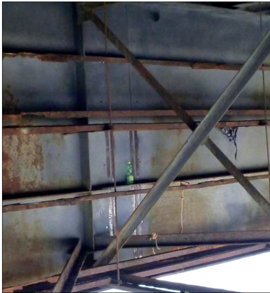
Рис. 5. Приклад контролю стикових вертикальних швів з'єднувальної вставки
