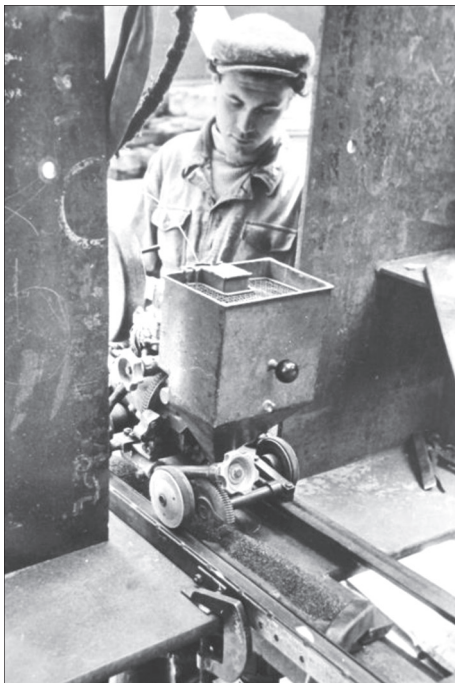
Рис. 2. Приклад застосування автоматичного зварювання під шаром флюсу нижнього поясу при стикуванні ферм головних балок [4]
