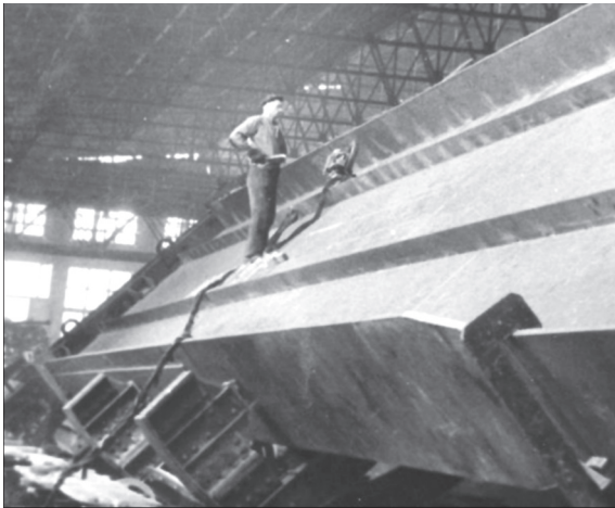
Рис. 1. Зварювання поздовжніх ребер жорсткості та поясних швів ферми [3]
